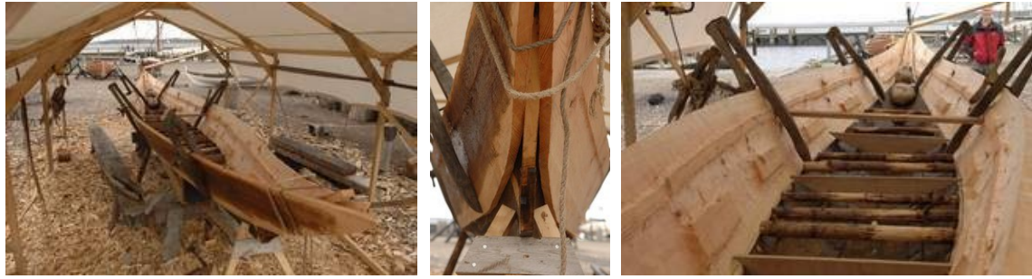
Montering af bådplanker.
